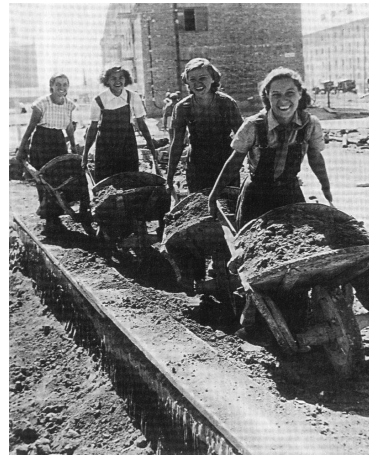
A Sztálinvárosi Vasmű építése
