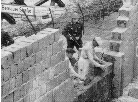
A fal építése katonai felügyelettel
